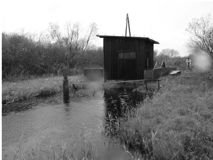
Ryc. 5. Pompownia na obszarze polderu Modła II Fig. 5. Pumping station on Modła II polder area
