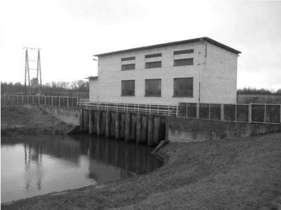
Ryc. 4. Pompownia na obszarze polderu Modła III Fig. 4. Pumping station on Modła III polder area
