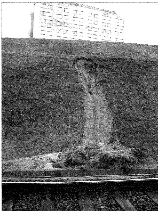
Fot. 3. Osuwisko na stoku wykopu PST (okres wiosennych roztopów) – widoczne zaburzenia roślinności po prawej stronie rynny osuwiskowej (fot. W. Mania 2005)
