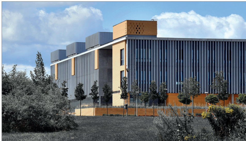
103. Budynek Wydziału Historycznego, według projektu Pracowni H.J. Buszkiewicz, oddany do użytku w 2015 r.
