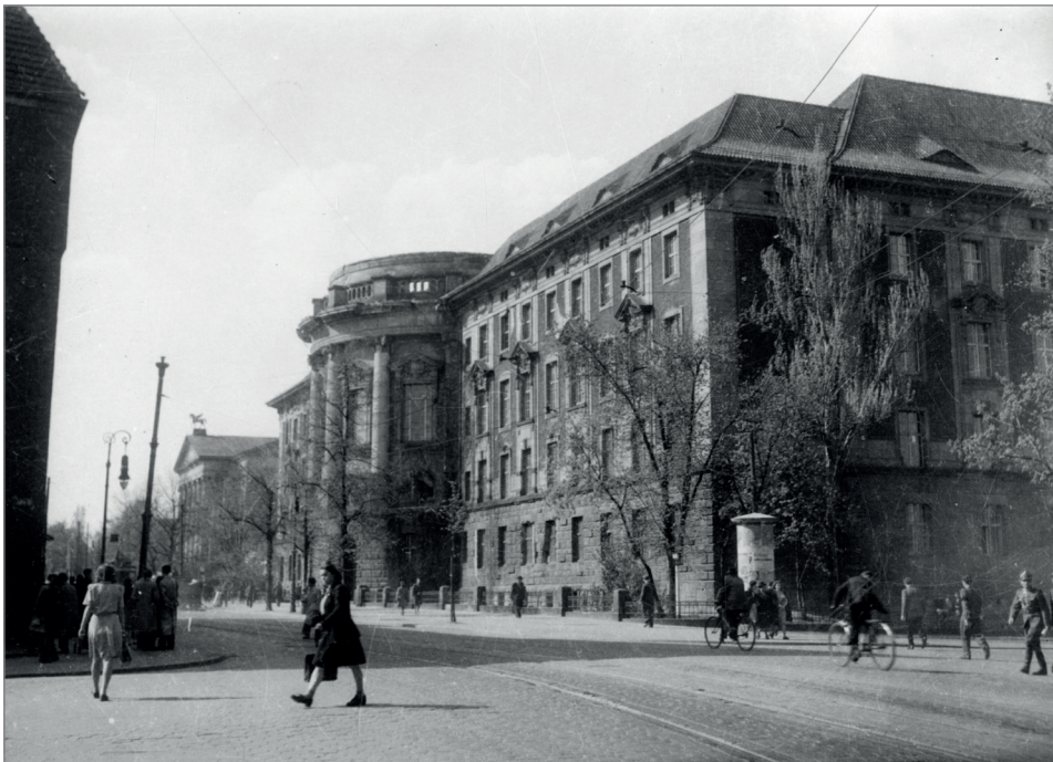
53. Gmach Collegium Medicum (ob. Collegium Maius) po odbudowaniu dachów, ale przed renowacją kopuły.
