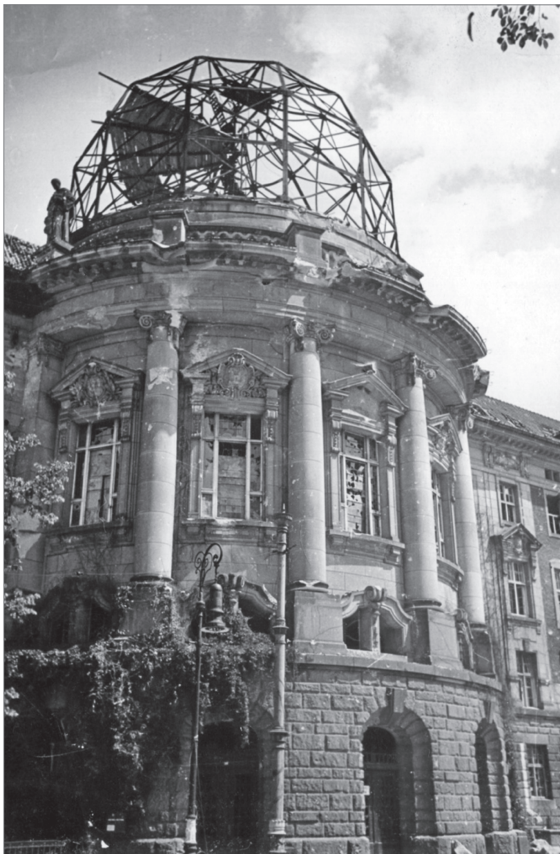
46. Powojenny stan Collegium Medicum (ob. Collegium Maius). Widoczny szkielet konstrukcyjny kopuły oraz jedna ocalała figura stojąca powyżej gzymsu, przedstawiająca mnicha cysterskiego jako alegorię średniowiecznej kolonizacji niemieckiej na Wschodzie. Stalową konstrukcję kopuły zdemontowano, pozostawiając przez kilka lat gmach bez charakterystycznego elementu. Collegium Medicum odbudowywano stopniowo, zaczynając od gmachu frontowego, następnie skrzydło od obecnej ul. Kościuszki.
