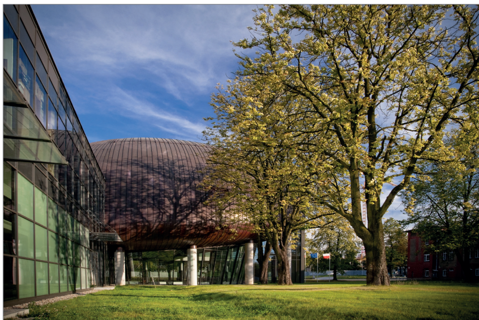
89. Na powojkowej działce przy al. Niepodległości, naprzeciwko hotelu Polonez, powstał według projektu Pracowni Projektowej 1997 nowoczesny gmach Collegium Iuridicum Novum, przeznaczony dla Wydziału Prawa i Administracji. Budynek został oddany do użytku w 2010 r.
