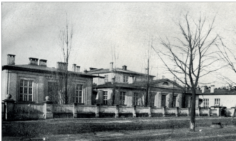
30. Budynek chemii ogólnej Wydziału Rolniczo-Leśnego był pierwszym gmachem w niepodległej Polsce zbudowanym na potrzeby szkoły wyższej. Powstawał w latach 1920–1925 w trzech etapach; uruchamiano stopniowo kolejne pawilony. Fotografia górna przedstawia fasadę ogrodową gmachu środkowego, zaś fotografia dolna widok od strony ul. Gołęcińskiej (ob. Wojska Polskiego).
