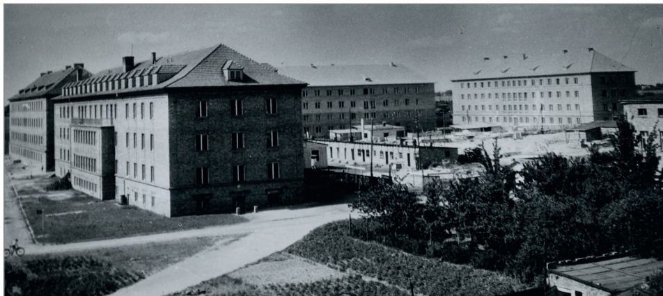
73a. Widok na budowane osiedle domów studenckich przy ul. Dożynkowej. Po lewej stronie ul. Jęczmienna. Po środku dom akademicki „B”, późniejszy DS „Babilon”. Od strony ul. Dożynkowej powstanie później jeszcze dom oznaczony literą „G”, a na dachu DS „Babilon” zostanie zbudowana charakterystyczna sygnaturka.
