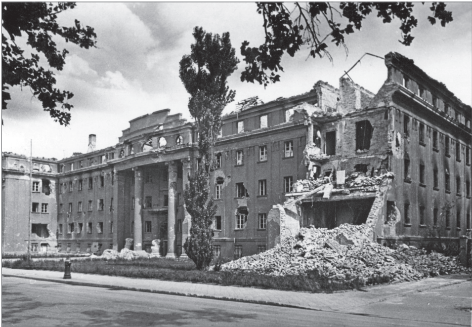
45. Widok wypalonego Domu Akademickiego przy Wałach Leszczyńskiego (ob. al. Niepodległości), zapewne z 1945 r. Można dostrzec dwie zburzone kolumny portyku, zerwane dachy, zburzone prawe boczne skrzydło, ślady po wypaleniach nad oknami w prawym skrzydle, ale już uprzątnięty gruz z ulic.
