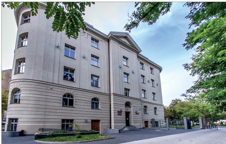
92. W latach 2011–2012 przeprowadzono gruntowny remont budynku przy al. Niepodległości 26, sąsiadującego z DS „Hanka”.
