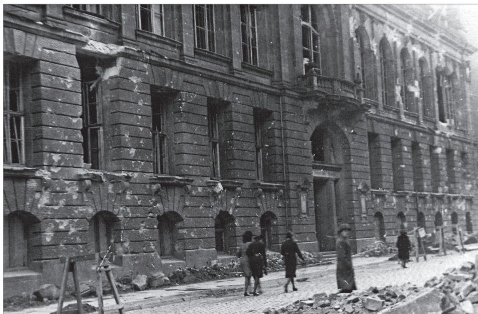
50. Fasada Biblioteki Uniwersyteckiej w pierwszej połowie 1945 r. Na zdjęciu widoczne uszkodzenia budynku oraz sterty gruzów leżące na ul. Ratajczaka.
