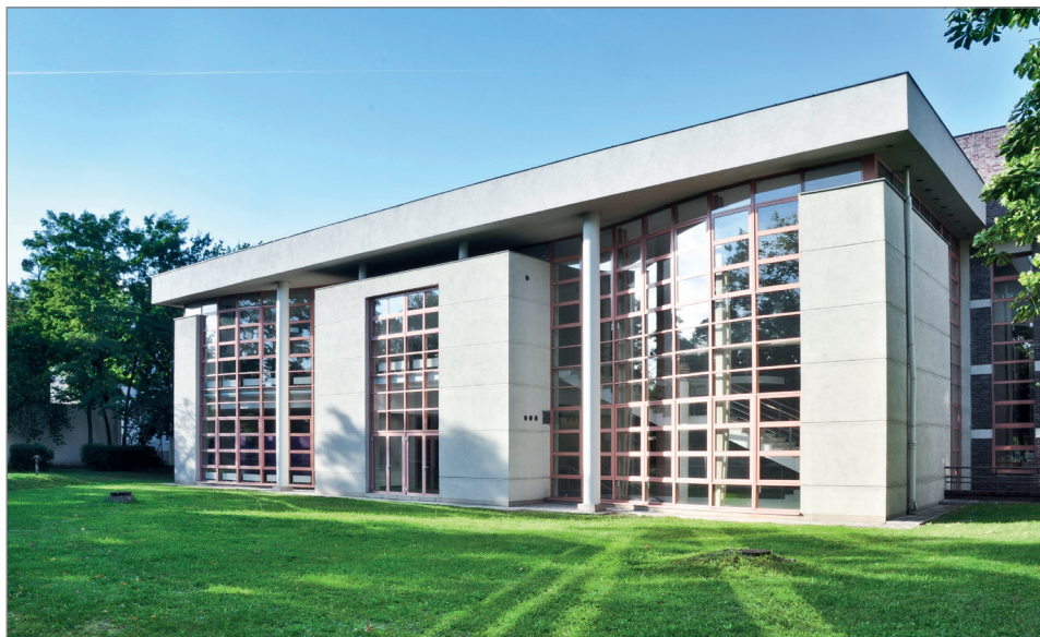
94. W zespole gmachów przy ul. Szamarzewskiego, w roku 2009 r. oddano do użytku budynek dydaktyczny według projektu Pracowni Projektowej 1997, nazwany w 2010 r. Collegium Floriana Znanięckiego.
