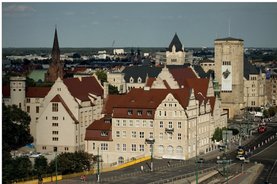
115. Odrestaurowane w latach 2009–2011 fasady historycznych gmachów uniwersyteckich. Na zdjęciu widoczne są Collegium Minus (po lewej) i Collegium Iuridicum (po prawej). W głębi bryła CK „Zamek”.
