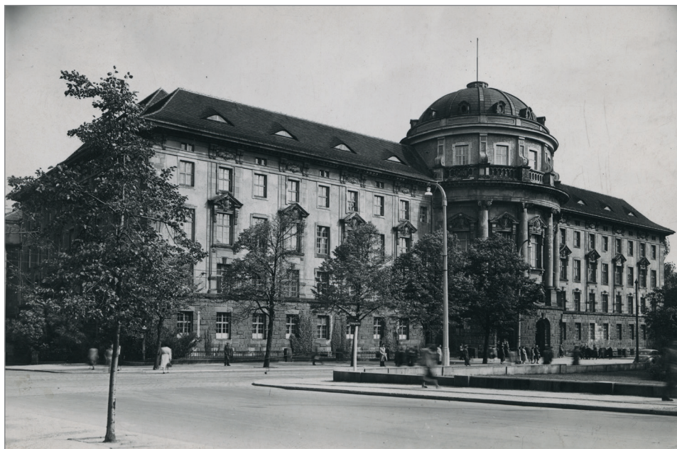
54. Gmach Collegium Maius z odbudowaną w 1956 r. kopułą. Została ona zrekonstruowana w obecnym, uproszczonym kształcie, bez wysokiego tamburu. Budynek stracił przez to dominujący, charakterystyczny element.
