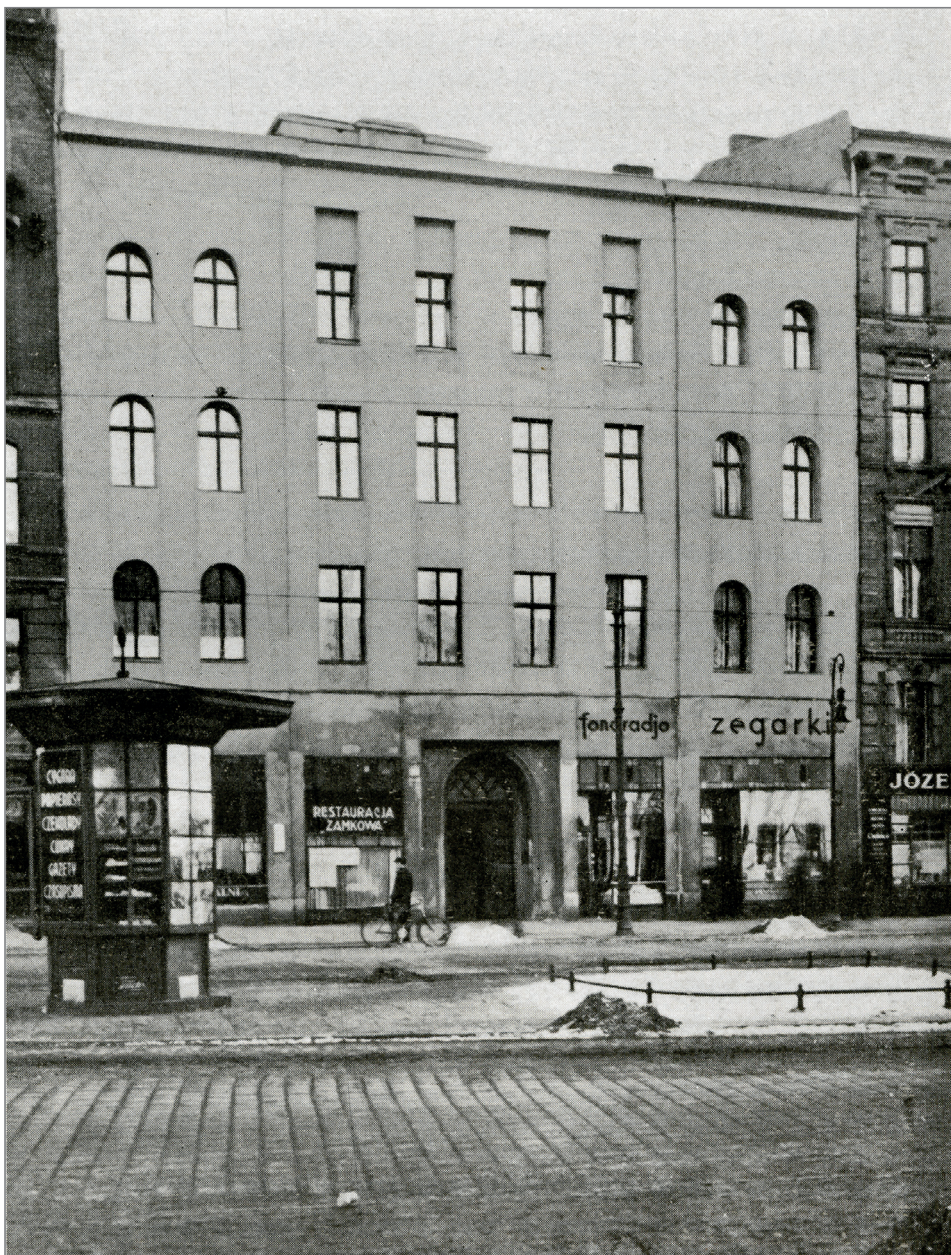
22. Budynek przy ul. Św. Marcin 40 (ob. 75), zbudowany na przeł. XIX i XX w., w którym w okresie międzywojennym znajdował się dom akademicki dla studentek. W lokalu po lewej stronie na parterze mieściła się restauracja oferująca tanie obiady, zaś po prawej lokale handlowe. W gmachu miała siedzibę Samopomocowa Organizacja Studentek Uniwersytetu Poznańskiego (SOS), a w podwórzu, w latach trzydziestych i w okresie powojennym – atelier uniwersyteckiego fotografa Witolda Czarneckiego „Wimar”.
