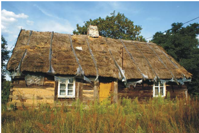
Ryc. 1. Jeszcze istniejące relikty tradycyjnego budownictwa. Chałupa o konstrukcji zrębowej i kryta strzechą we wsi Stara Kaźmierka w Puszczy Puzdrskiej (fot. A.W. Brzezińska, 2009 r.)
