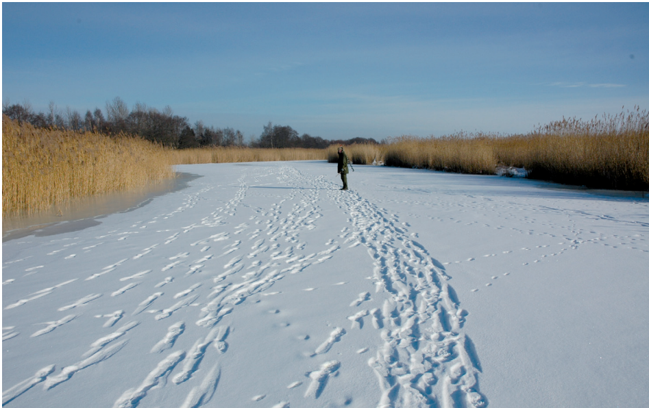
Fot. 1. Nurt Jamneński przed budową (A) i w trakcie budowy wrót (B) – widok z mostu (droga Mielno–Łazy) w kierunku północnym, kanał skuty lodem (C) (fot. A. Choiński, A – 2009, B – 2013, C – 2010)
