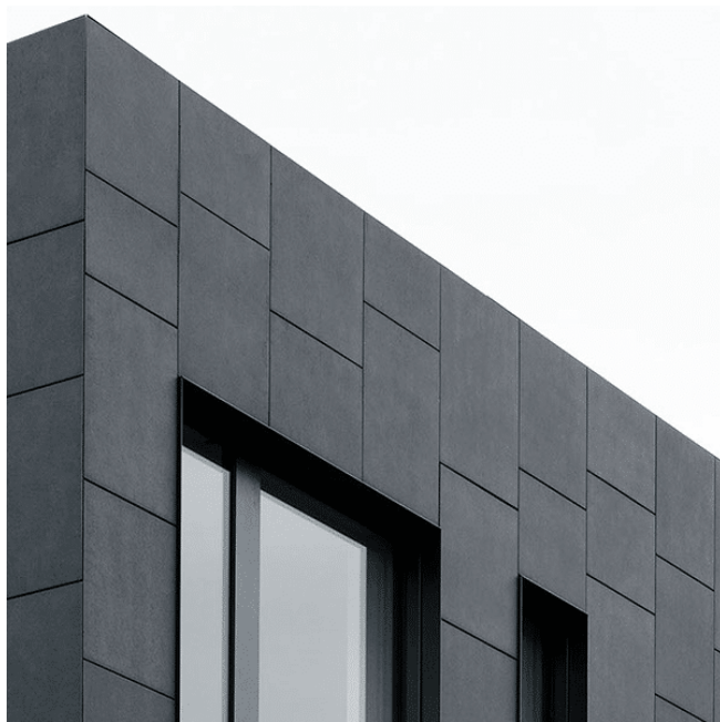
Zdjęcie 16. Przykład fotowoltaicznej okładziny fasadowej
