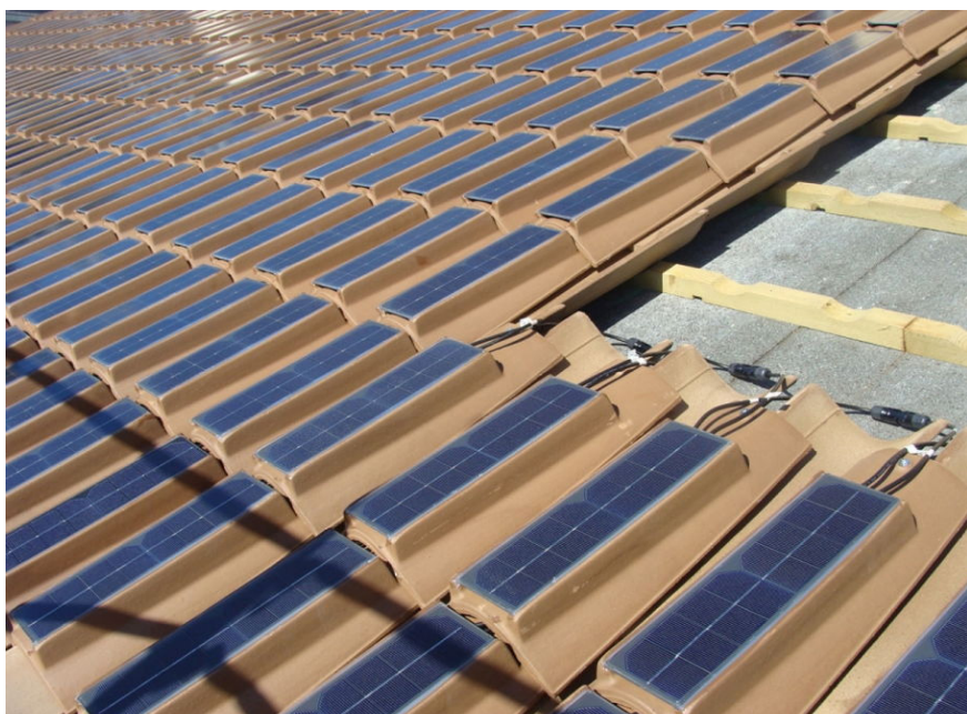
Zdjęcie 14. Dachówka fotowoltaiczna o kroju nawiązującym do lokalnych tradycji architektonicznych
