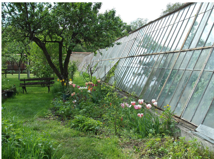
Ryc. 5. Wnętrze ogrodu gołuchowskiego z lokalizacji siedemnastowiecznej lub starszej giardino segreto . Widok szklarni przy murze północnym, konstrukcja szklano-żelazna z 1889 r. Fot. G. Ławniczak, 2020
