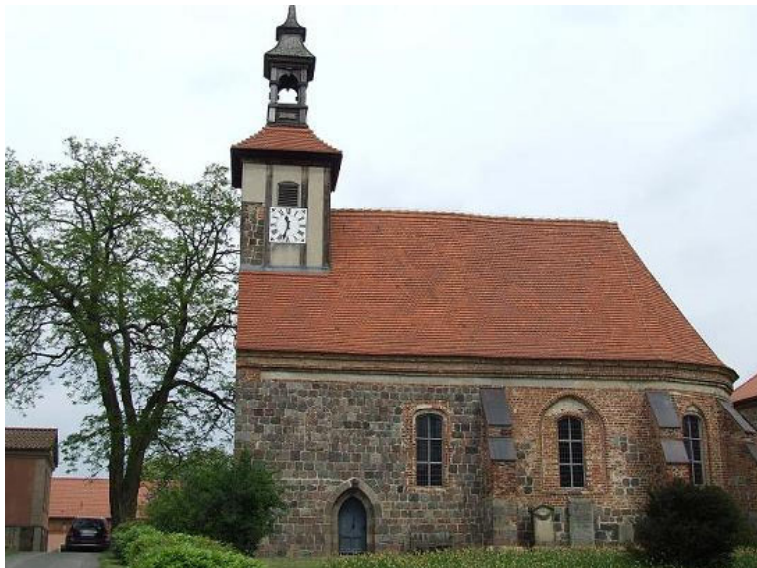
Kaplica w Leśnicy od strony południowej, fot. nr 5 (K. Wasilkiewicz)
