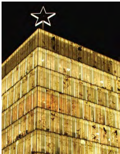
fot. 11 Onyks jako materiał elewacyjny zapewniający oryginalne efekty oparte na penetracji światła, budynek Louis Vuitton , Osaka (MK 2010)
