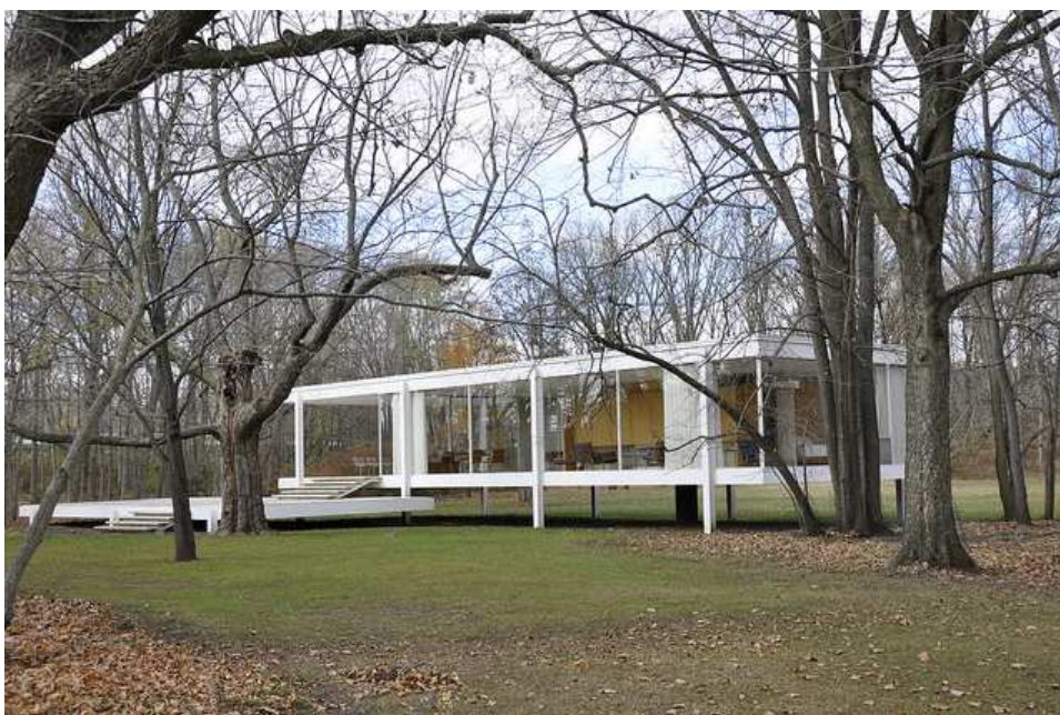
Farnsworth House (1951), widok z przodu, Plano (Illinois), Mies van der Rohe, fot. Jamie Schafer 422
