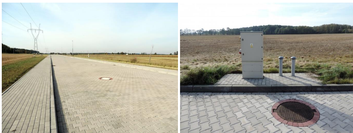
Ryc. 74. Przygotowanie infrastrukturalne Strefy aktywizacji gospodarczej w Czerniejewie.
