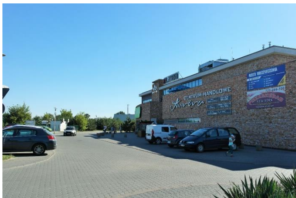
Fot. 5. CH Aurora – centralny punkt i lokalna dominanta osiedla Osada Leśna.
