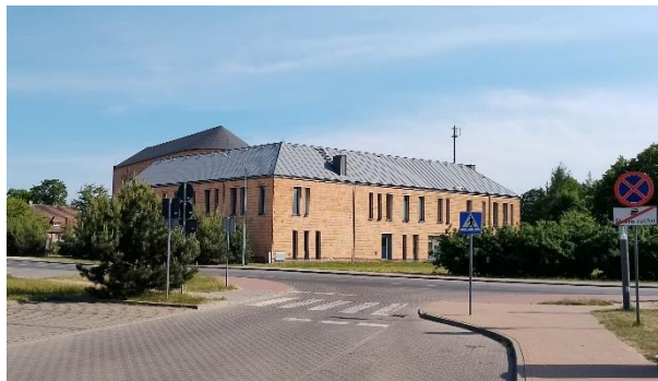
Fot. 2. Powstający zespół sakralny w Dąbrówce. Źródło: fot. własna.
