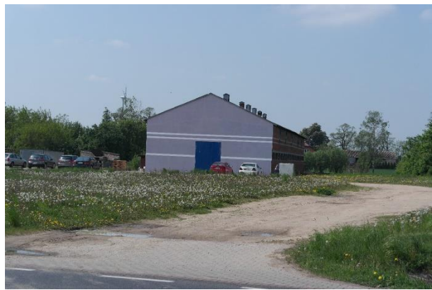
Fot. 35. Czołowo-Kolonia - stodoła wykorzystywana na potrzeby produkcyjne. Fot. własna.
