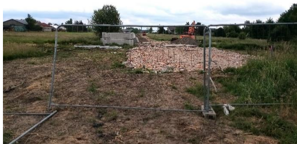
Fot. 11. Osiedle Książenice. - budowa mostku na Rokitnicy łączącego ul. Cichociemnych z Mazowiecką.
