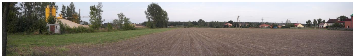
Fot. 36. Czołowo-Kolonia - wytwórnia mas bitumicznych w sąsiedztwie zabudowy. Fot. własna.
