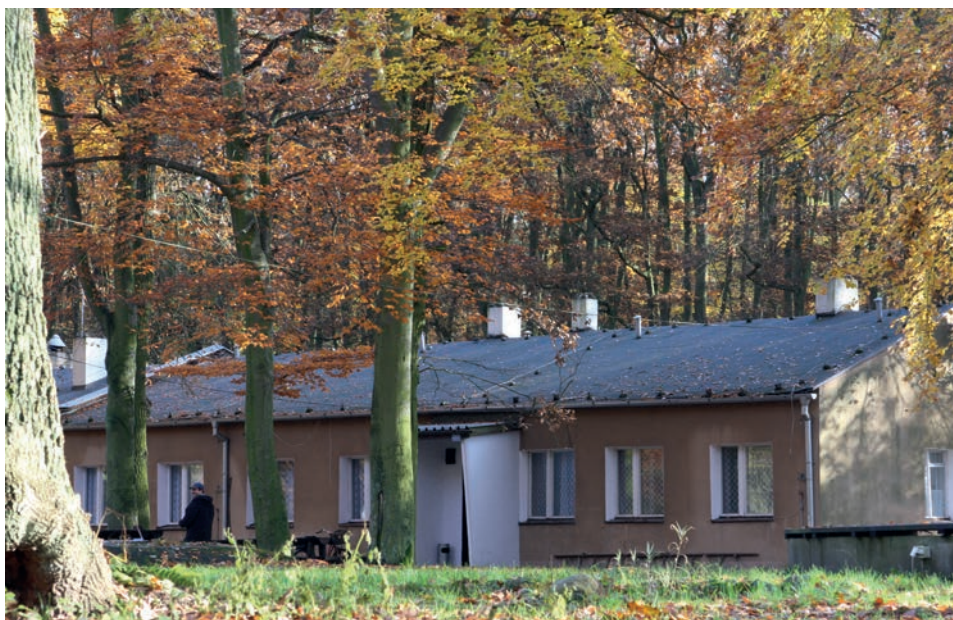
Ryc. 4. Budynek noclegowy (fot. M. Lorenc)
