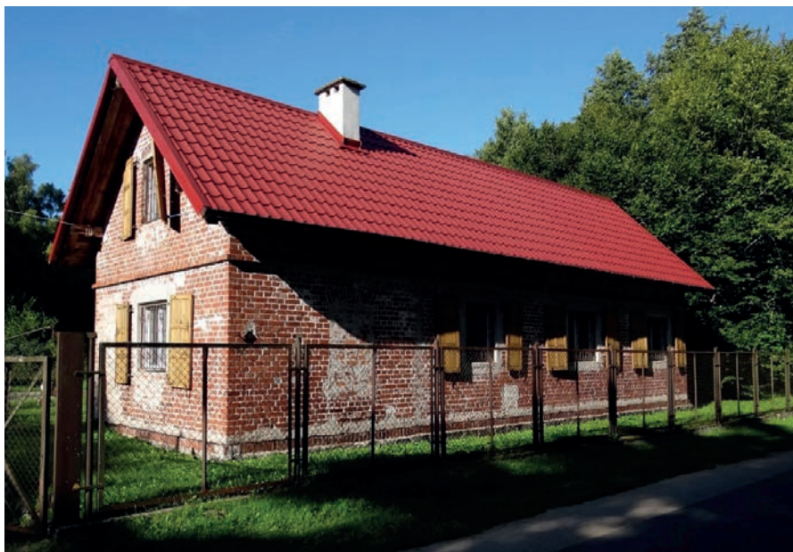
Ryc. 2. Drugi budynek Stacji Terenowej w Czołpinie (fot. J. Czerniawska, 2012)
