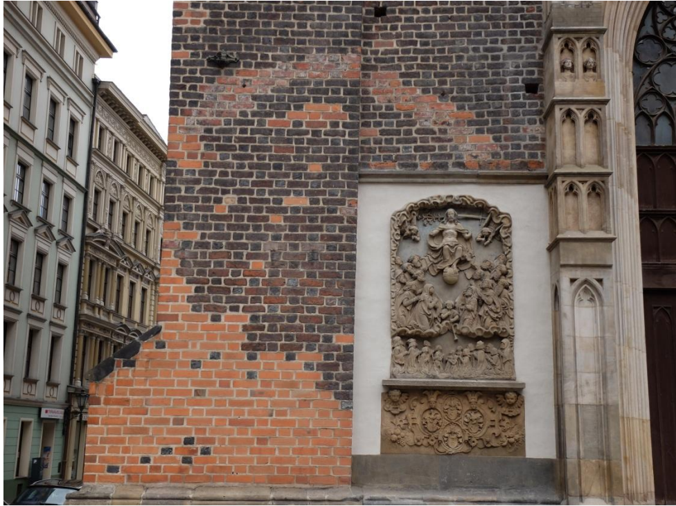
Il.58. U góry: Epitafium Krappów na zewnętrznym murze wieży [fot. P.Ł.].
