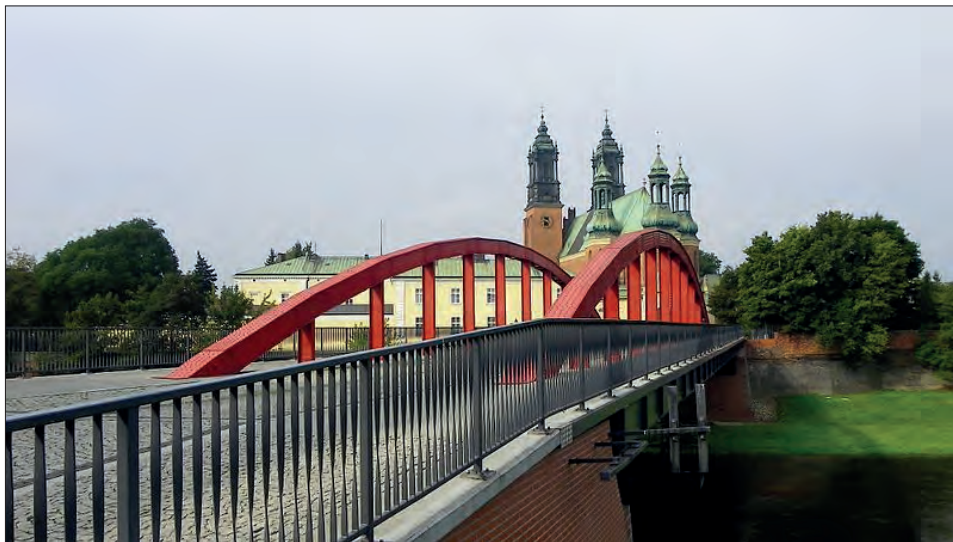
Fot. 2. Most Jordana – odtworzenie historycznej przeprawy przez Cybinę w ramach rewitalizacji Ostrowa Tumskiego i Śródki
