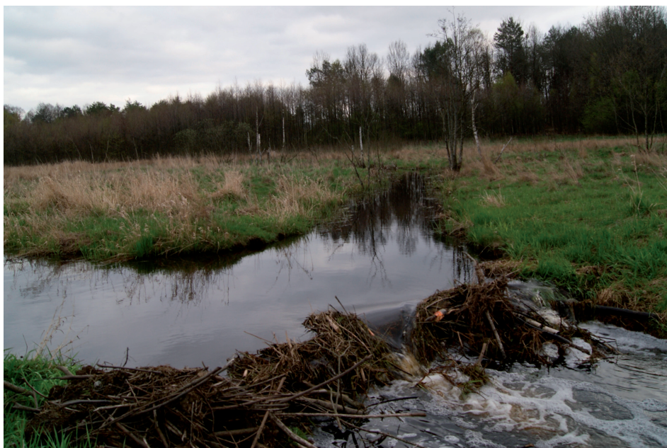
Fot. 4. Odpływ wody przez kanały ulgi (kwiecień 2016) Photo 4. Water outflow through the relief channels (April 2016)
