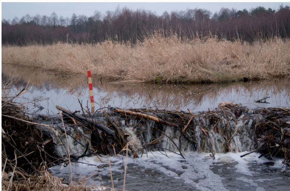
Fot. 3. Odpływ wody przez koronę tamy (luty 2016) Photo 3. Water outflow through the crown of the dam (February 2016)
