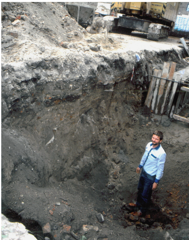
Fot. 1. Warstwa nasypowa na terenie szeroko rozumianego centrum Poznania osiąga 3–4 m miąższości
