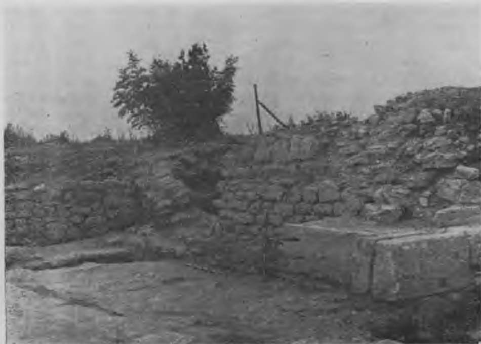
Fig. 3. Tour No 4. Vue du côté sud-ouest
