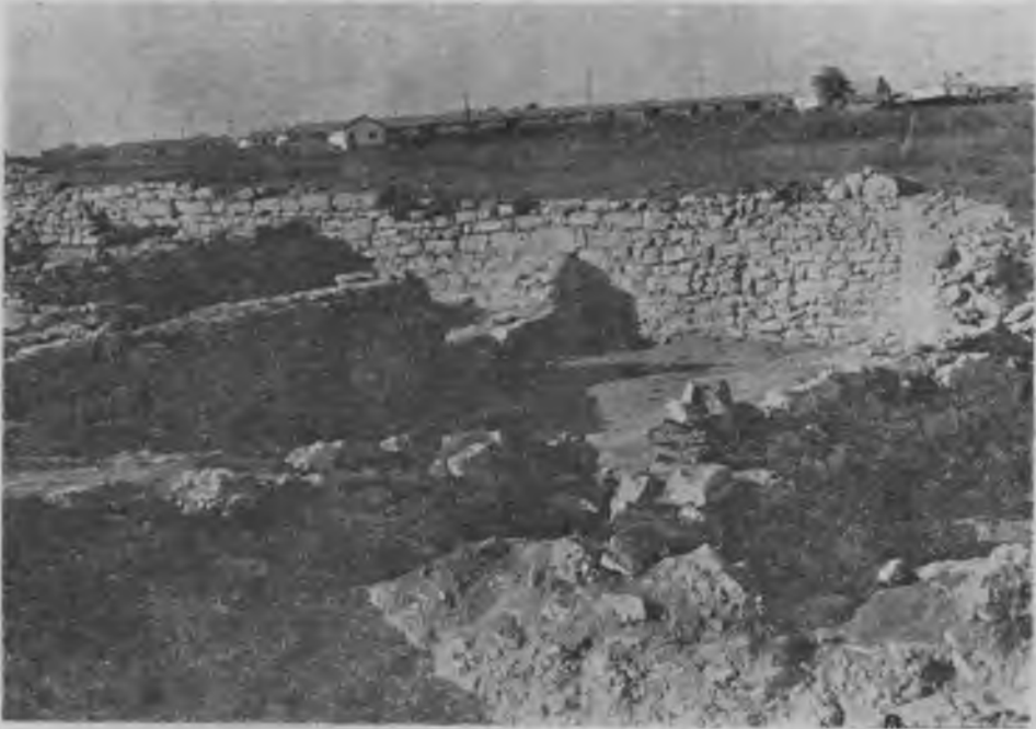
Fig. 2. Mur d'enceinte septentrional. Vue du côté sud-est
