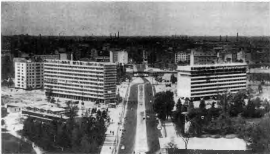
8. Altonaer Straße w czasie budowy (po lewej galeriowiec proj. F.Jaenecke, S. Samuelson, po prawej – O. Niemeyer), 1957 (?) ( Interbau Berlin. Amtlicher Katalog , Berlin 1957)
