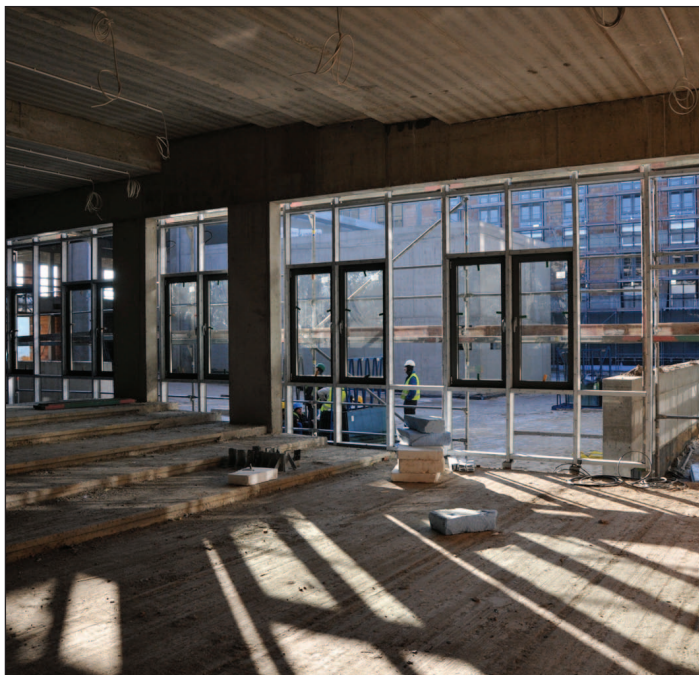
Budowa gmachu w kwietniu 2014 roku
