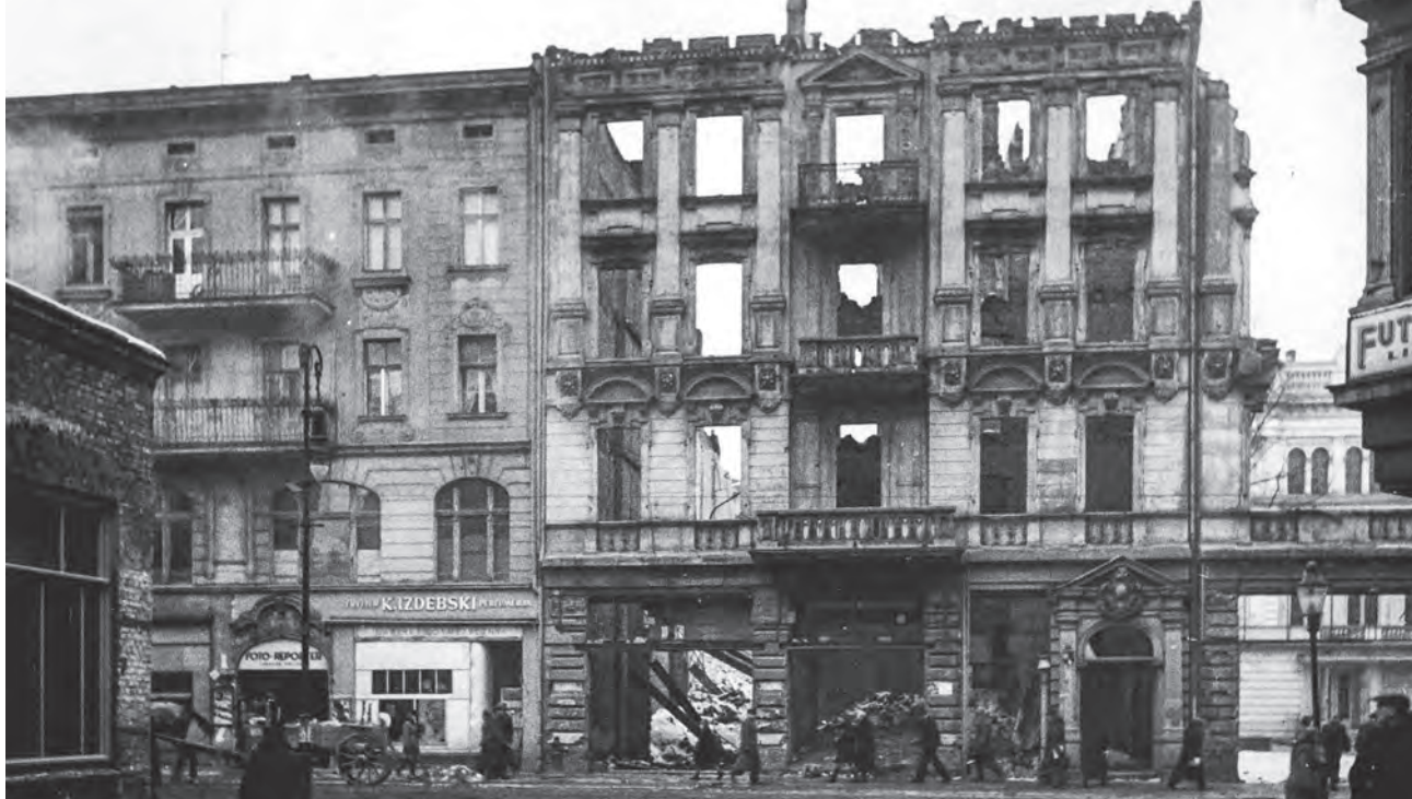
Il. 31 Zniszczone kamienice na ul. 27 Grudnia. Widok od strony dzisiejszej ul. Kantaka. Po prawej stronie widoczny fragment budynku Teatru Polskiego
