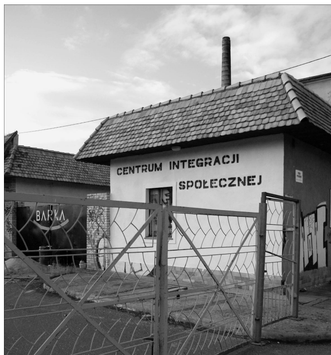
Centrum Integracji Społecznej w dawnych budynkach fabryki konserw fot. Bartosz Stańda, Poznań, 2010
