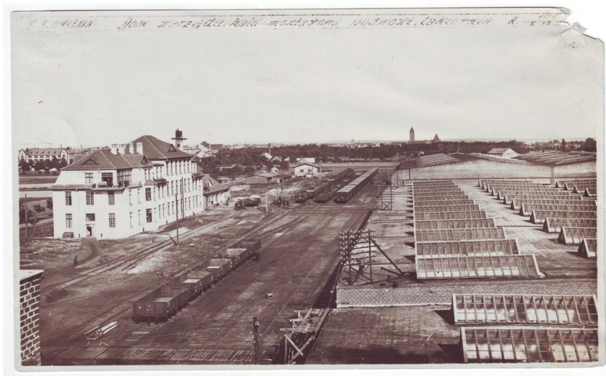
Fabryka „Wagon” w trakcie budowy 1920 -1922. Ze zbiorów MMOW, nr inwentarza 00922.
