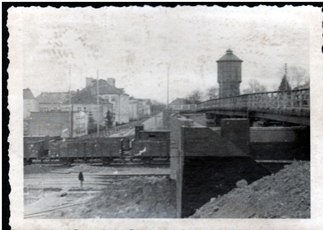
Budowa w ramach planu Otto mostu kolejowego przy ul. Parkowej (Schleswig Straße). Ze zbiorów MMOW.
