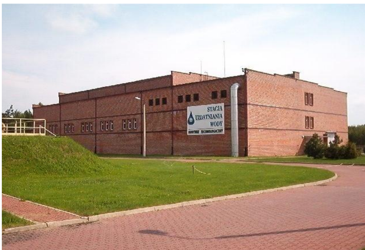
Stacja uzdatniania wody Przedsiębiorstwa Wodociągów i Kanalizacji S.A. w Ostrowie Wlkp. oddana do eksploatacji w 1994 r. Źródło: http://wodkan.com.pl/?page_id=1020 .
