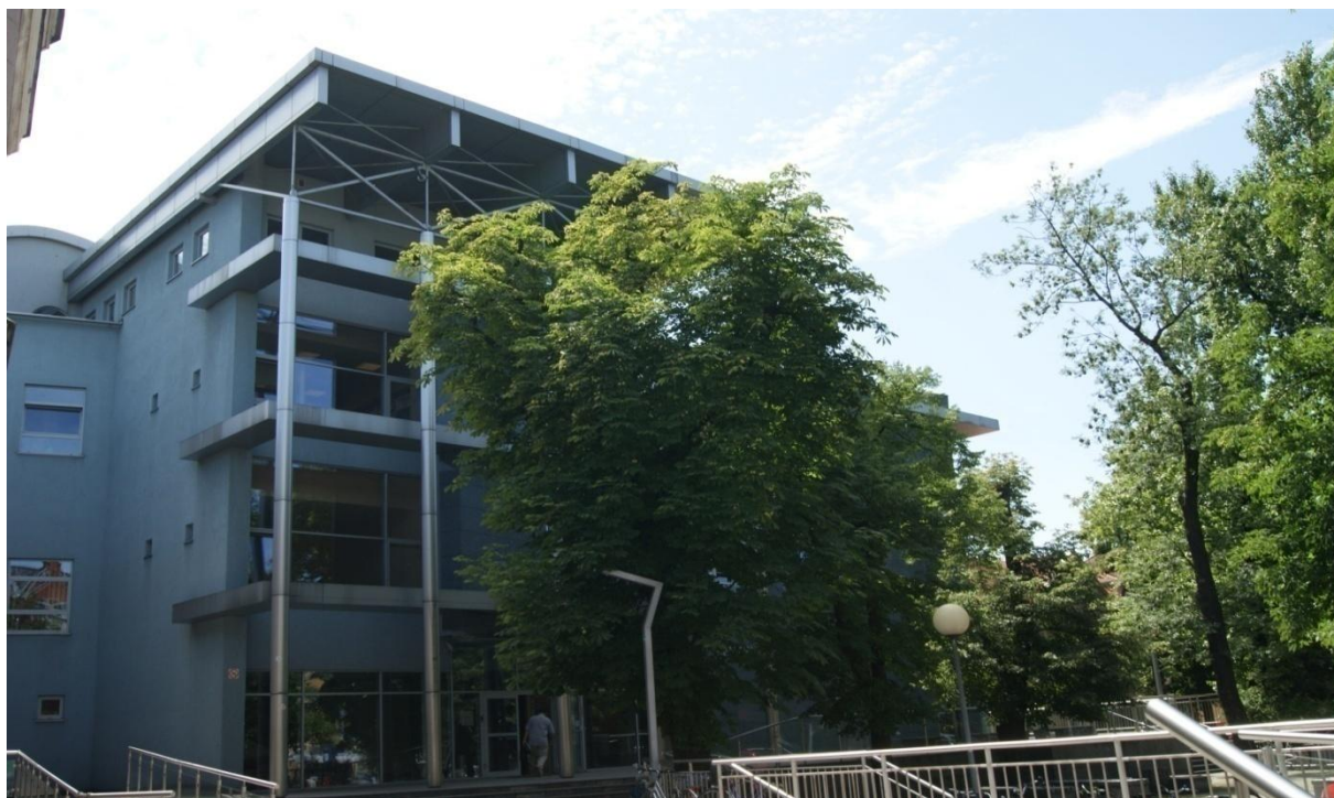
Budynek Biblioteki Publicznej im. Stefana Rowińskiego w Ostrowie Wlkp. wzniesiony w latach 1998 – 2001. Fotografia ze zbiorów własnych autora.
