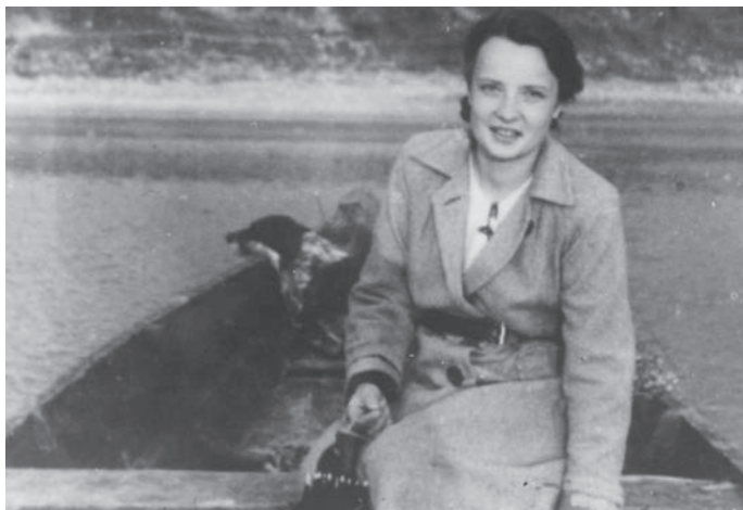
Elżbieta Krajewska na przeprawie przez Wisłę na wyspę Kępę. Majątek Hemplów w Wałowicach, okres okupacji
