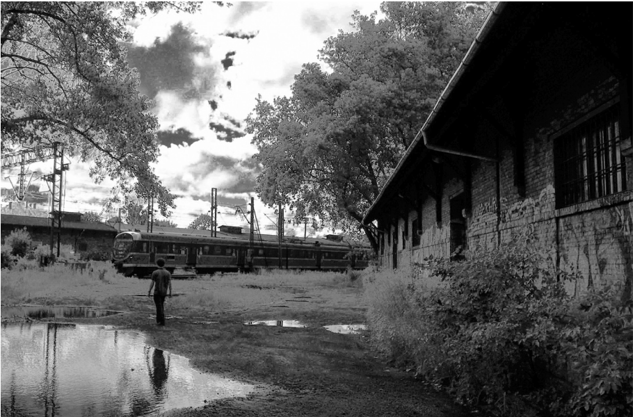
Fot. 2. Widok na linię kolejową Kraków-Katowice przecinającą teren Dworca Towarowego. Po prawej jedna z hal magazynowych Fot. Agnieszka Zaborska-Jagielto.
