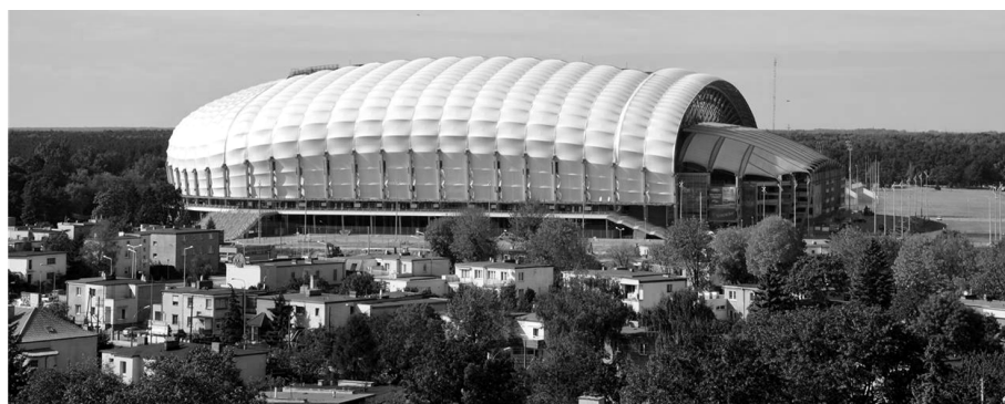
Fot. 2. Stadion Miejski, wrzesień 2011
