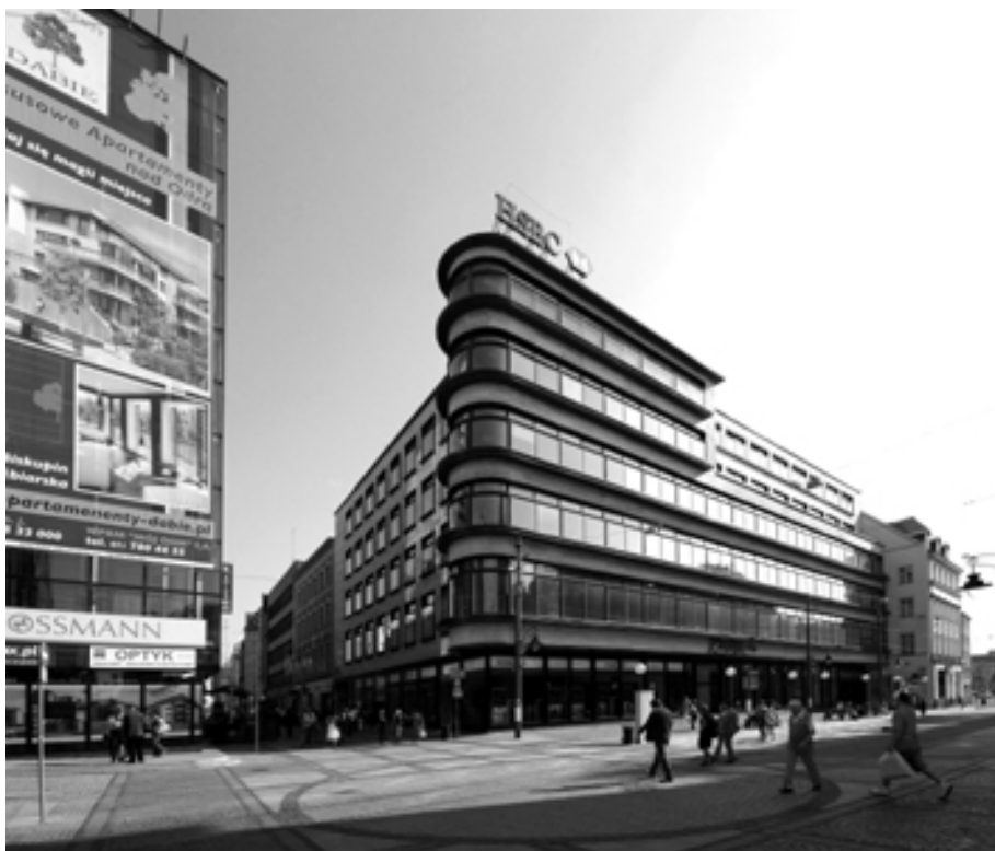
Fot. 2. Perła wrocławskiego modernizmu, dom handlowy Kameleon przy ul. Szewskiej 6/7, dawny Konfektionhaus Rudolf Petersdorff, zaprojektowany w 1927 r. przez Ericha Mendelsohna. Stan po rewaloryzacji w 2009 r.
