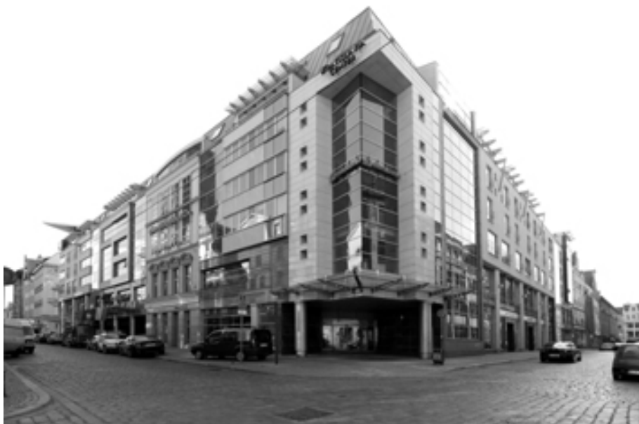
Fot. 4. Wratislavia Center z Hotelem Sofitel przy ul. św. Mikołaja 67-76. Projekt z 2001 r., arch. Leszek Łękawa. Stan obiektu z 2010 r.
