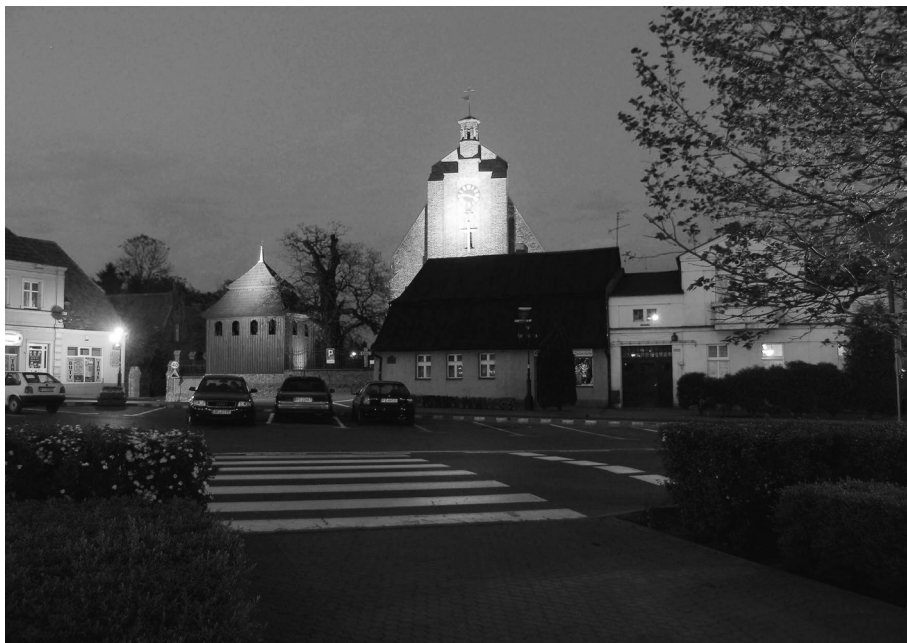
Fot. 3. Realizacja zagospodarowania przestrzenno-oświetleniowego zabudowań Rynku w Pobiedziskach
