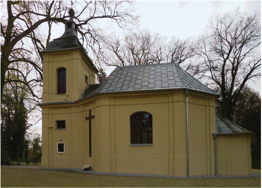
Kaplica pw. Narodzenia NMP, elewacja zachodnia, fot. E.P., 2014
