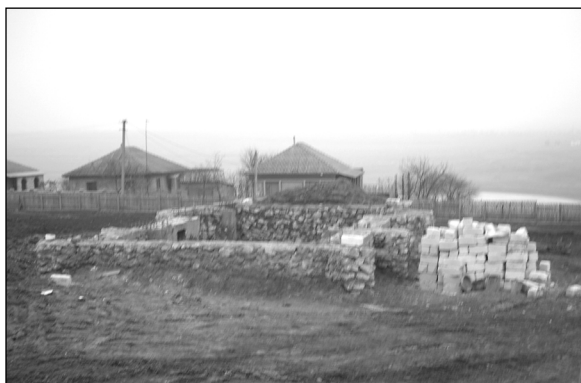
Буджак – строительство новой церкви.
