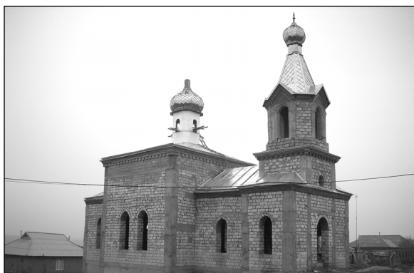
Верхний Конгазчик – строительство новой церкви.
