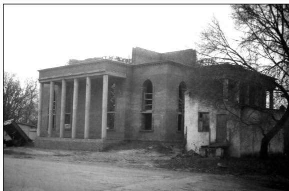
Вулканешты – строительство новой церкви (2006 г.).
