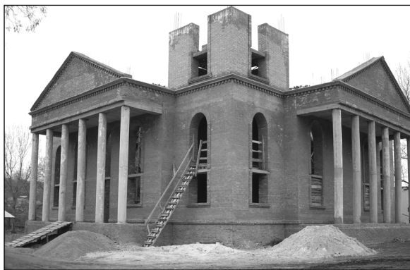
Вулканешты – строительство новой церкви (2008 г.).
