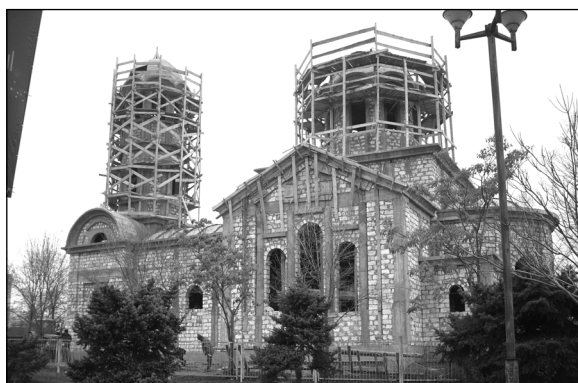
Чадър-Лунга – строительство новой церкви (2008 г.).
