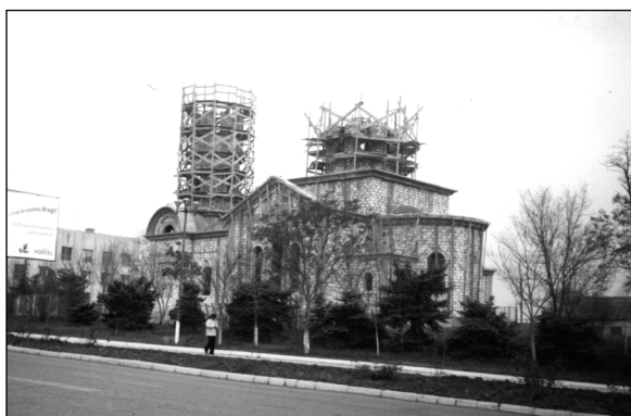
Чадър-Лунга – строительство новой церкви (2006 г.).
