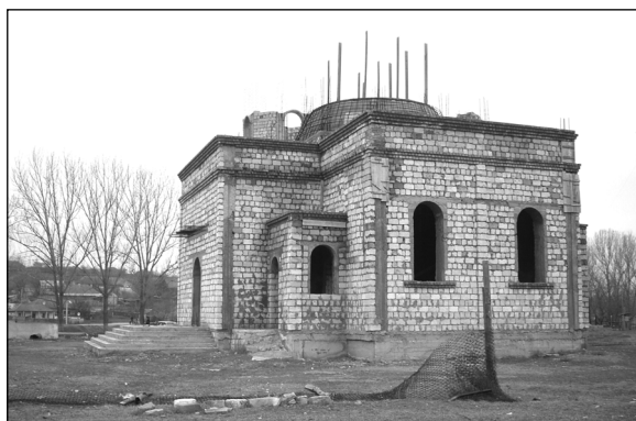
Чишмикиой – строительство новой церкви.
