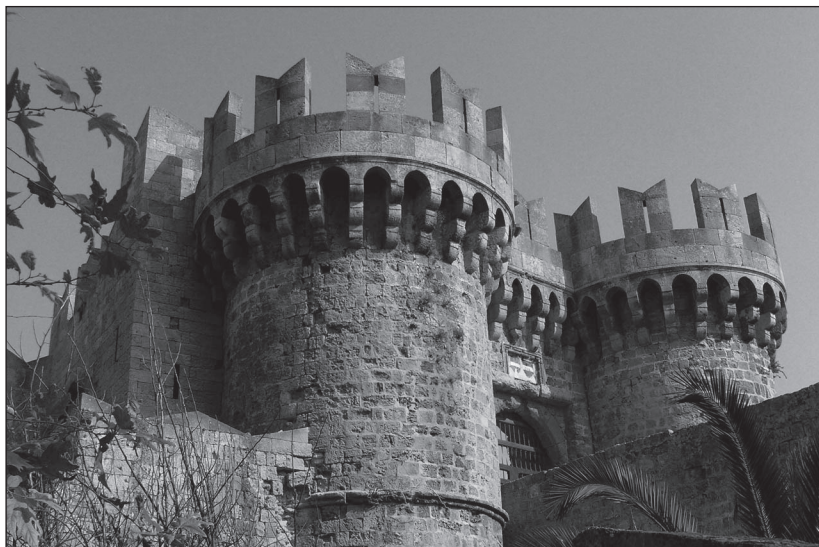
Fot. 50. Nawet potężne bastiony nie potrafią ustrzec wielkich potęg przed zanikiem pamięci – Rodos
