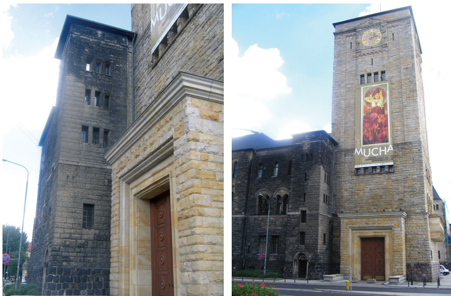
Fot. 1, 2. Zachodnia elewacja Zamku Cesarskiego w Poznaniu (od strony ringu, obecnie Alei Niepodległości) w trakcie procesu czyszczenia
