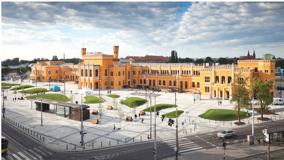
Fot. 5, 6. Przebudowa wrocławskiego Dworca Głównego i placu przed nim, przeprowadzona na podstawie projektu Grupy 5 Architekti Sp. z o.o. Inwestor Polskie Koleje Państwowe SA. Stan budowy w lipcu 2011 r. i w maju 2012 r. Fot. 7, 8. Opanowana przez pieszych przestrzeń publiczna przed Dworcem Głównym. Stan z 2013 r. Fot. 9. Plac przed Dworcem Głównym we Wrocławiu. Widok z lotu ptaka, stan z lipca 2012 r.
