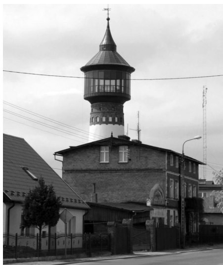
Ryc. 9. Wieża ciśnień w Łobzenicy po modernizacji, 2013
