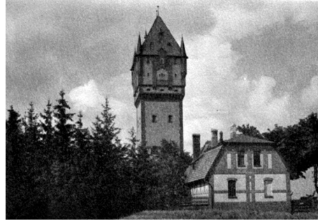
Ryc. 11. Zabytkowa zabudowa zespołu wieży ciśnień w Kościanie, ok. 1900 r.
