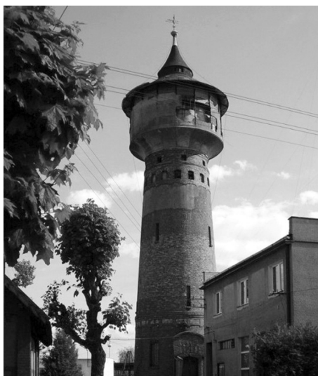
Ryc. 8. Wieża ciśnień w Łobzenicy przed modernizacją
