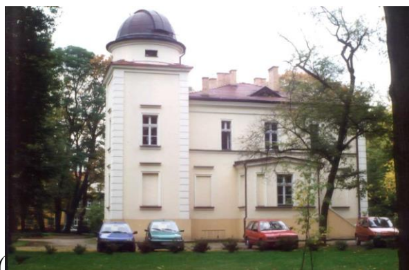
Budynek OA w 2000r.
