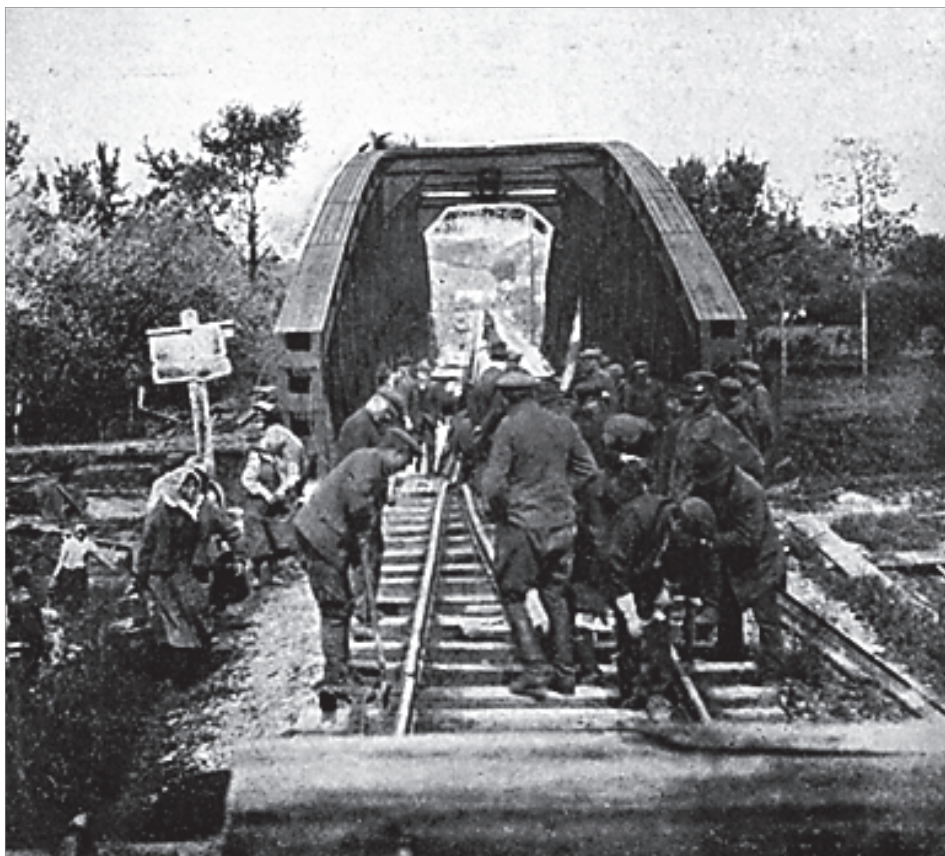
11. Załoga „Odsieczy I” przy naprawie mostu na linii kolejowej Rawa Ruska – Belz.
