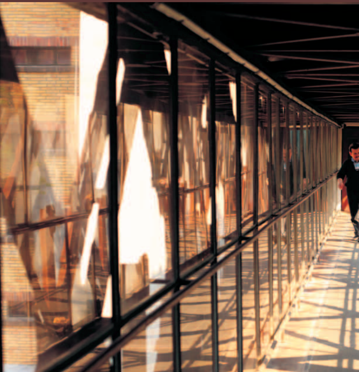
Przejście łączące stary gmach Biblioteki Uniwersyteckiej z nowym magazynem.
